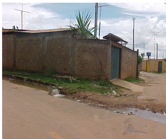
Figura 3 - Ruas residenciais típicas da Zona Urbana da área Central de São Sebastião. Observa-se a enxurrada de água de nascente sobre capa asfáltica.
